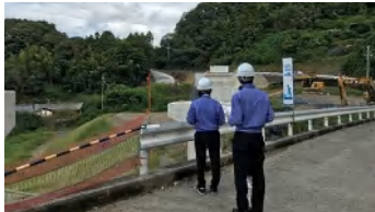
和歌山の工事現場を視察中
